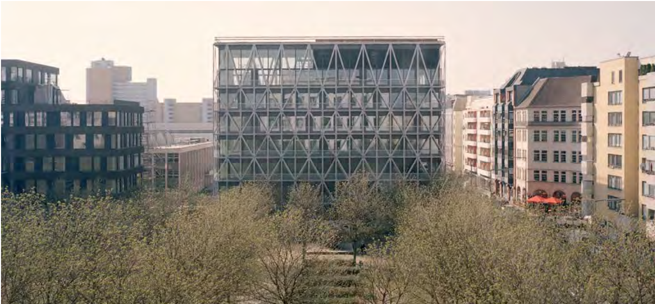
Abb. 19: Neubau taz (E2A / Piet Eckert und Wim Eckert /Architekten ETH BSA SIA AG, Zürich), Foto: Rory Gardiner
